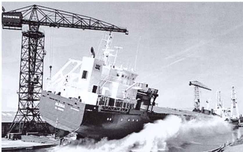
Querstelllauf bei Bodewes Jachtwijk: „Alesia“ für die Reederei Erwin Strahlmann
